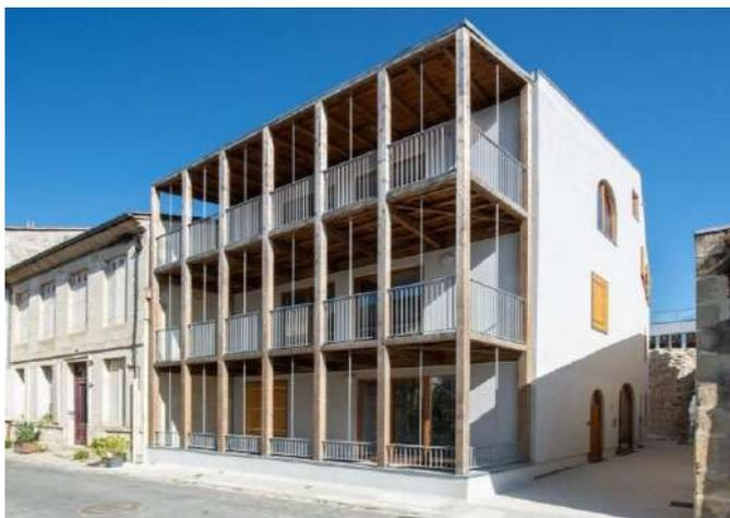
Figure 6 : Protections solaires - Rénovation Le Jardin sur le Toit – La Réole
